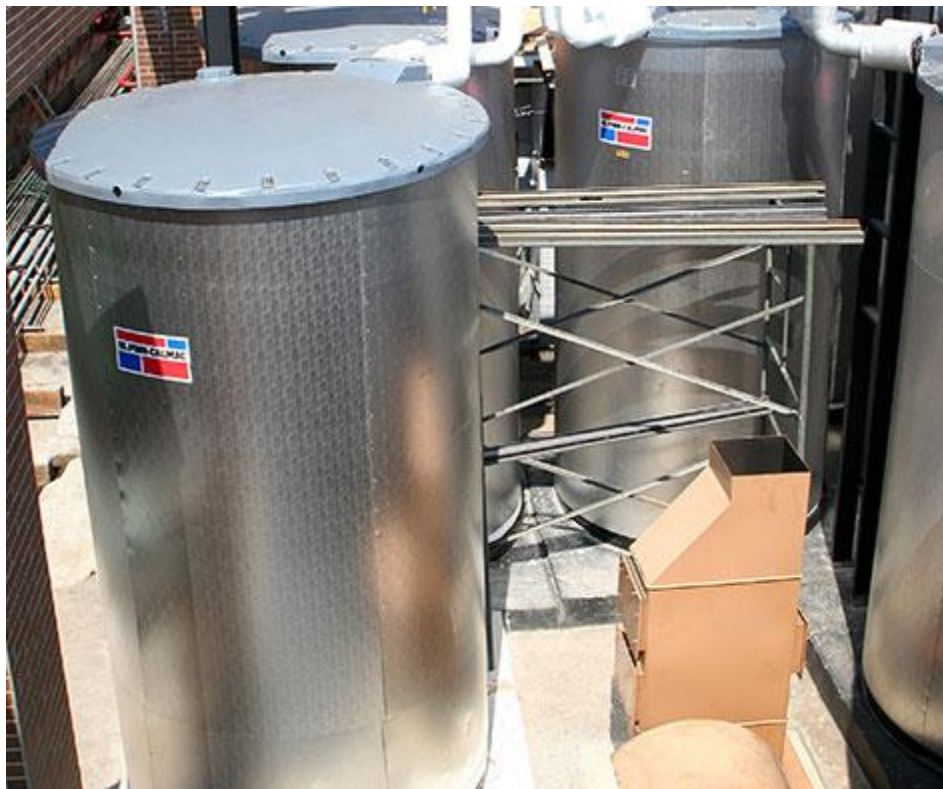
Figura 29 – Exemplo de tanque de gelo para termo acumulação.
