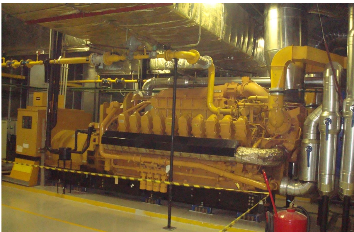
Figura 19 – Gerador a gás com reaproveitamento do calor rejeitado para chiller de absorção.
